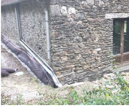
Un drainage et un nouveau seuil.
